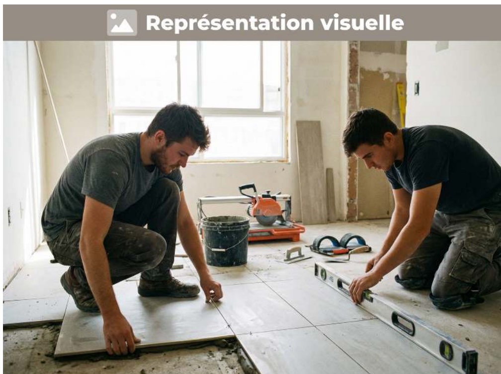
Pose de carrelage en 8 heures par deux ouvriers, perte estimée 12%
