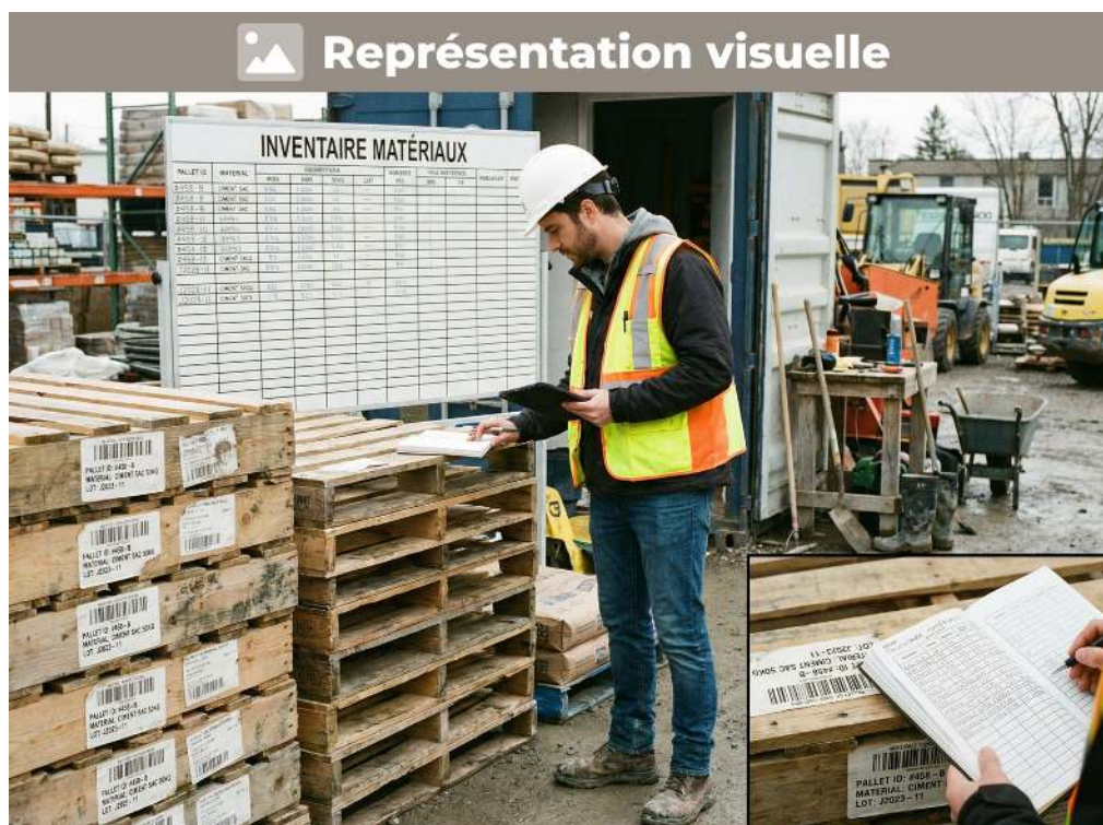
Contrôle des palettes avec un système FIFO pour optimiser les matériaux
